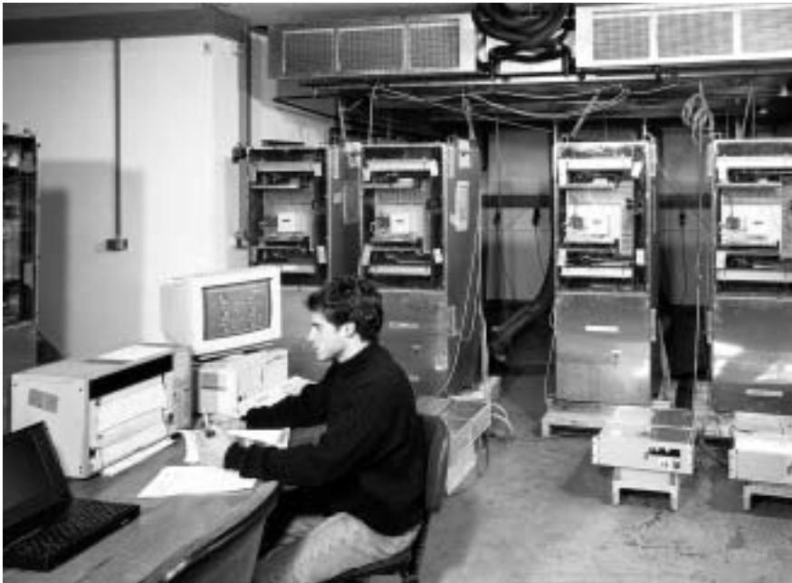
Abnahmeprüfung von Weiss-Klimasondergeräten für Wafer-Stepper
